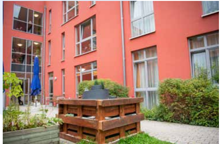
Modernes Gebäude mitten in der Hansestadt Wismar: die Seniorenpflegeeinrichtung "St. Martin".
